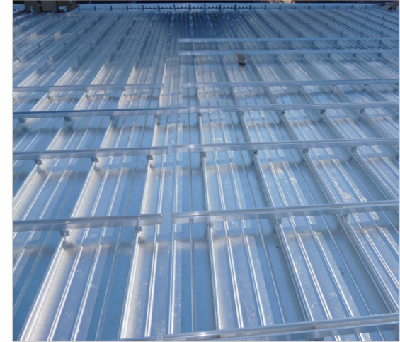
Szyna C montowana na klemie na rąbek okrągły
