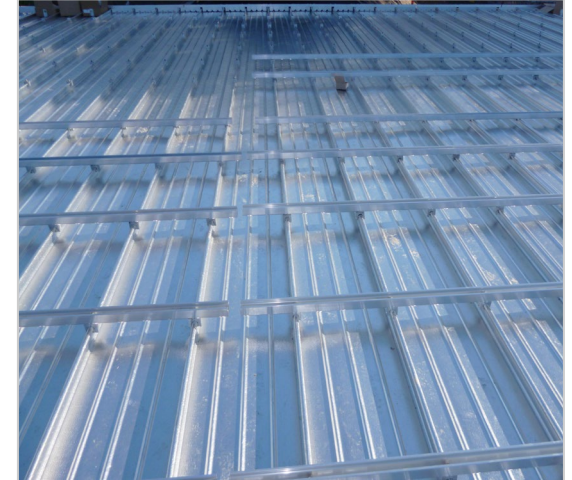
C-Schiene auf Rundfalzklemmen
