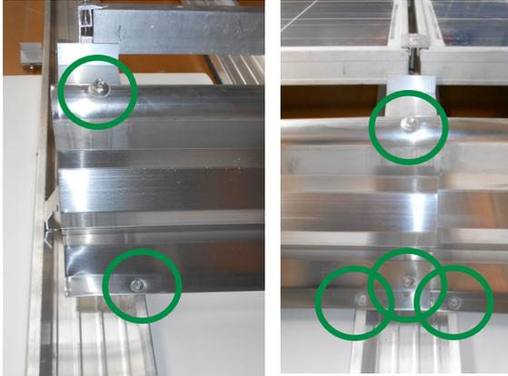
Guíe el deflector de viento desde arriba por la curva de los soportes del módulo y colóquelo sobre los raíles de base. Fíjelo en el borde del sistema con al menos dos tornillos de fijación. En el centro del sistema deben utilizarse cuatro tornillos de fijación.
