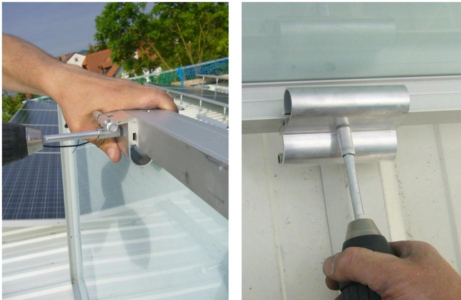
Abbildung 29: Montage „Modulbefestiger-Set“ hinten (links) und vorne (rechts)
