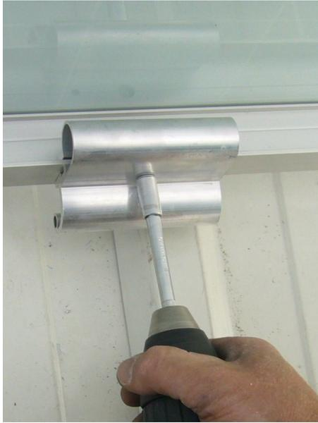
Abbildung 63: Montage „Modulbefestiger-Set“ vorne
