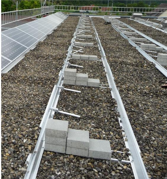
Abbildung 30: Eingelegte Modulstützen-Set
