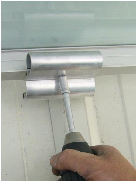
Abbildung 45: Montage „Modulbefestiger-Set“ vorne
