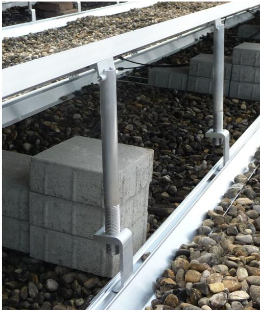
Abbildung 31: Höhenverstellbare Modulstützen
