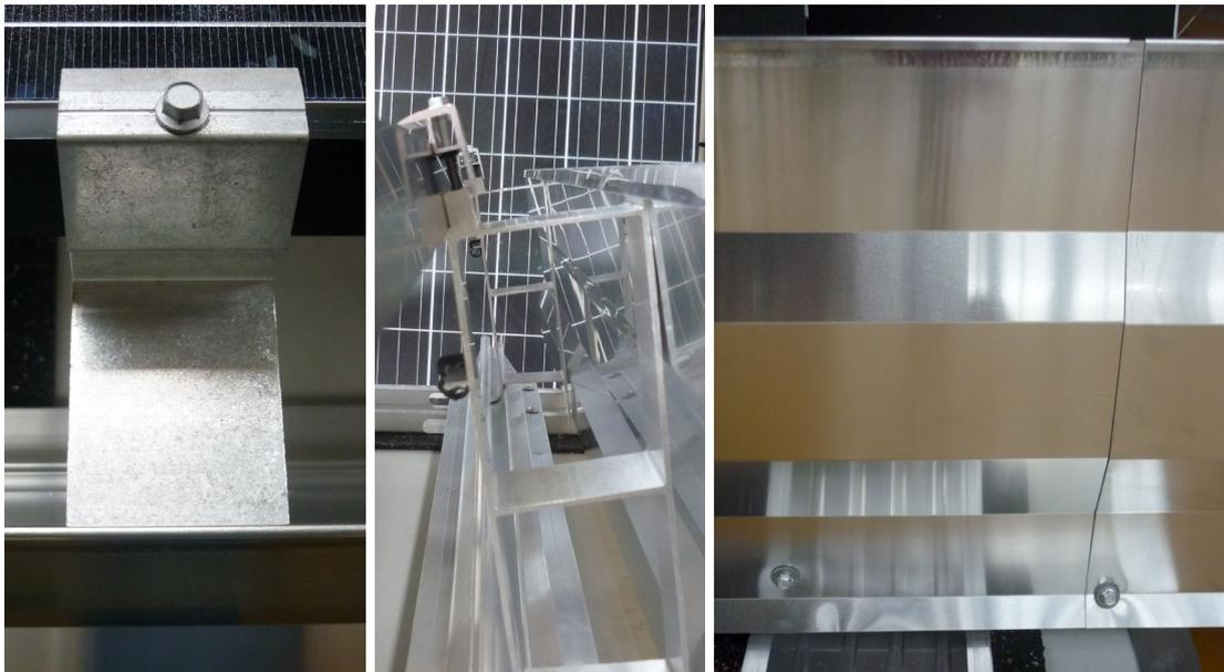
Abbildung 47: Montage Windleitbleche
