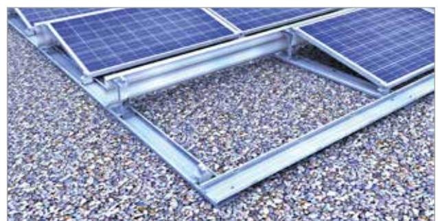
Cubierta de grava: sistema Sur cerrado II colocado sobre grava
