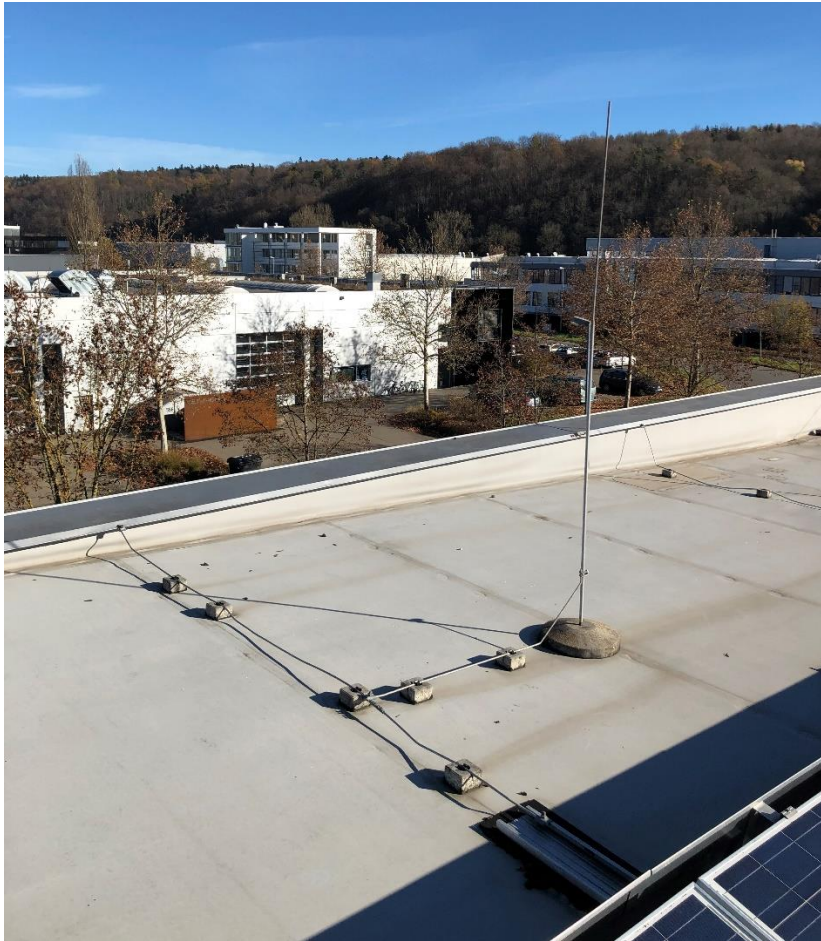
Detail Fs: Variante alte separate Blitzfangstange bleibt weiter bestehen und wird angebunden (MK). Bei der Anbindung an die Attika fehlt der Ausdehnungsbogen
