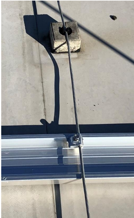
Detail E: Lösungsvariante: bestehender Blitzschutz wird so belassen bzw. wieder vollständig aufgebaut und die PV-Anlage wird angeschlossen (MK)
