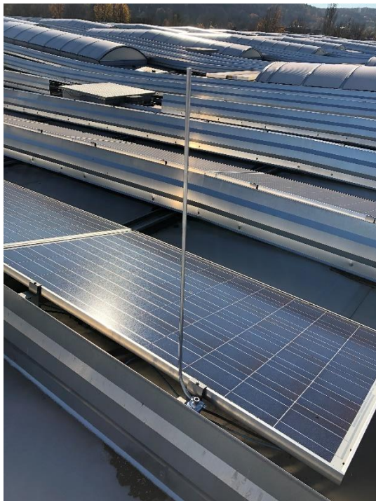
Detail Fv: Blitzfangstange an Modulstütze angeschlossen: horizontale Anbindung (MK) mit Fangstange aus gebogenem Runddraht
