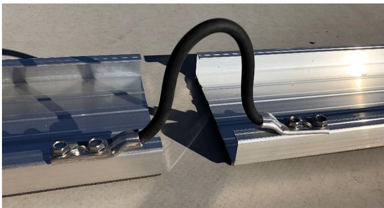
Detail C: Überbrückung (US) bei der Dehnfuge (Grundschiene längs)
