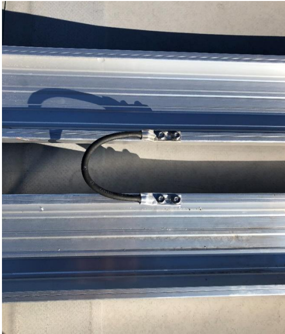
Detail B: Überbrückung (US) bei der Dehnfuge (Grundschiene parallel)
