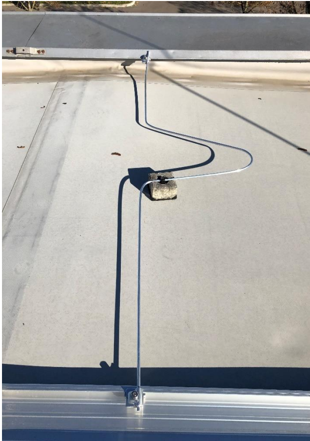
Detail A: Anschluss der PV-Anlage an das Attikablech mit Dehnungsbogen (MK)
